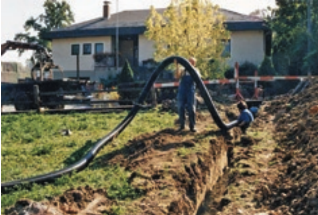
Erdverlegte Nahwärmeleitung vor dem Zuschütten der Künette. Foto: Polytechnik
