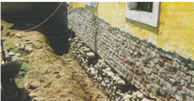
Mauerwerk abgegraben. Foto: "die umweltberatung"
